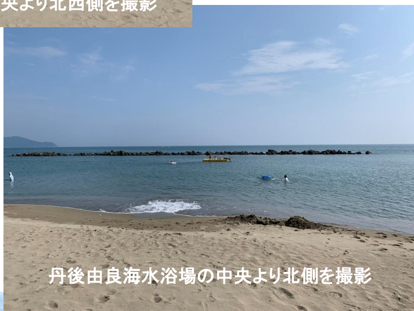
丹後由良海水浴場の中央より北西側を撮影
