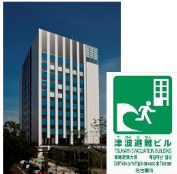
図-4 津波避難ビル 1)
