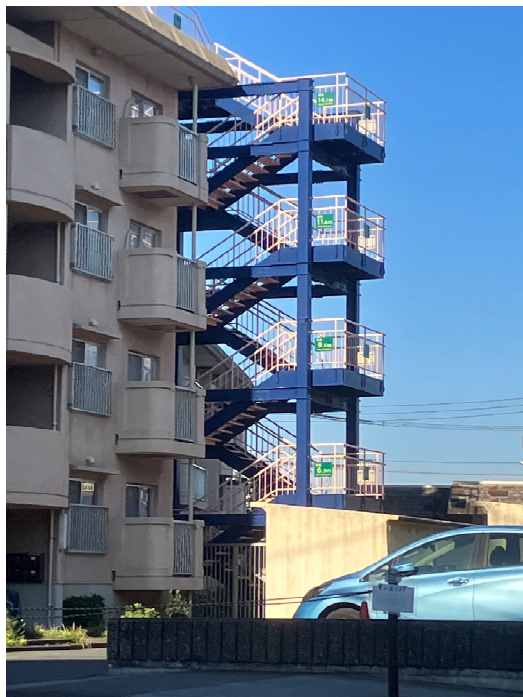
図-3 津波避難階段を備えた建物
